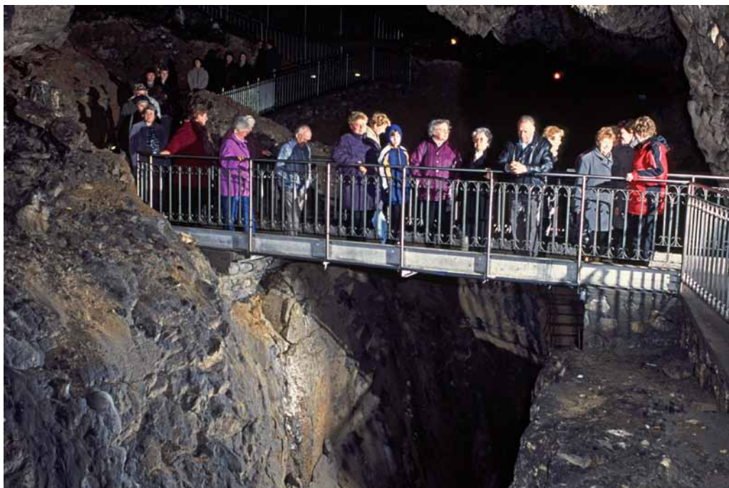
Most přes Stupňovitou propast byl vybudován až během poslední rekonstrukce. Foto: Petr Zajíček
