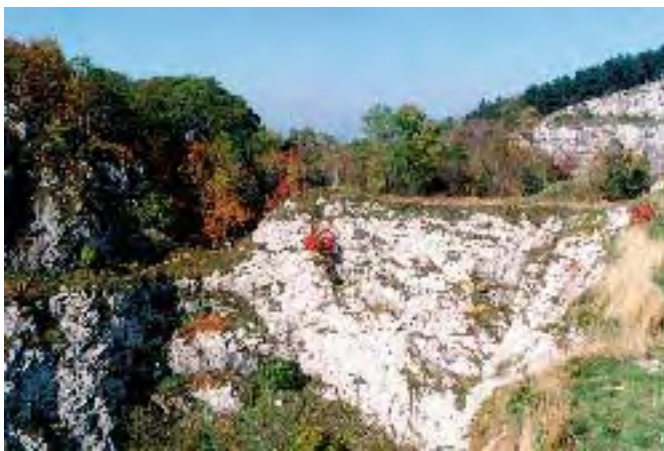
Z úpatí skalních stěn byly odstraněny náletové dřeviny (jasan, akát)
